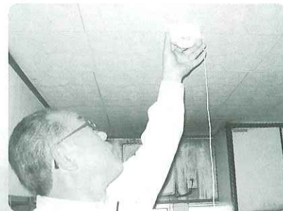
▲火災報知器も設置しました。
